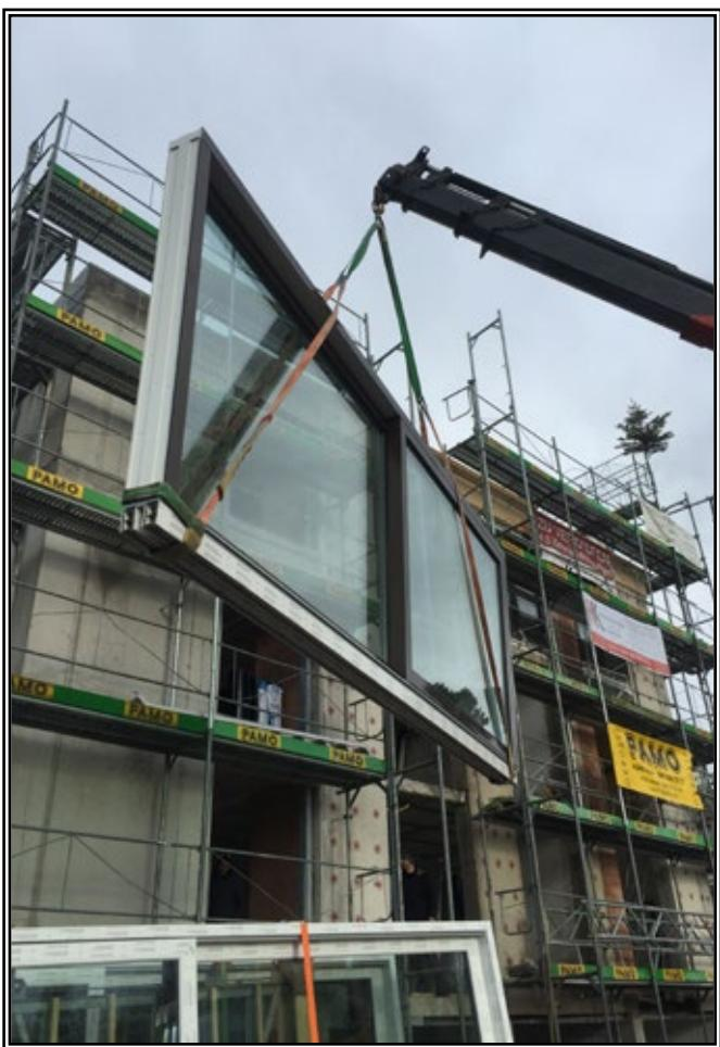
Vertikalni transport naših podizno-kliznih vrata u Švajcarskoj
